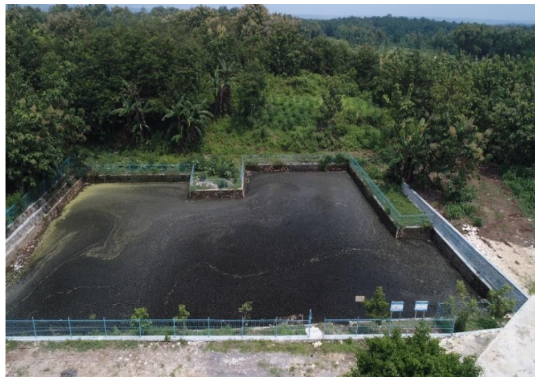
Gambar 4.9. Kolam Pengumpul Lindi Dalam Keadaan Penuh (Sumber : Foto Udara dengan menggunakan Drone/Dokumentasi Pribadi)
