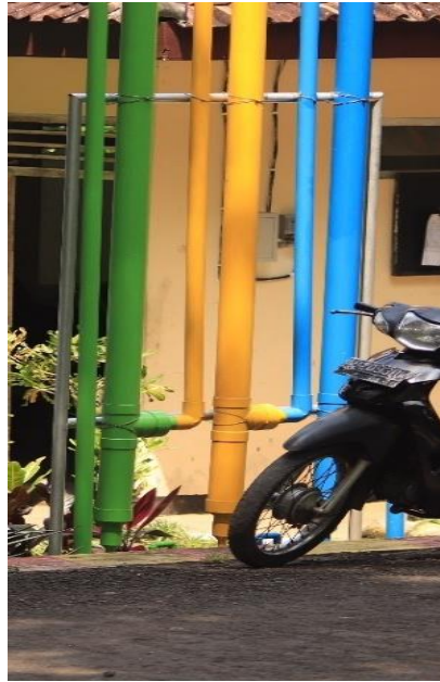
Gambar 4.10 Instalasi Pipa Gas Di Halaman Pos Jaga
