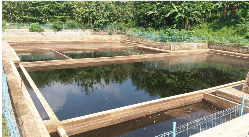
Gambar 4.8. Kolam Pengumpul Lindi Dalam Keadaan Normal
