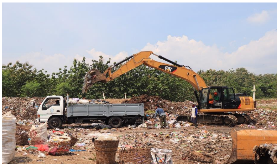
Gambar 4.16 Alat Berat Jenis Excavator
