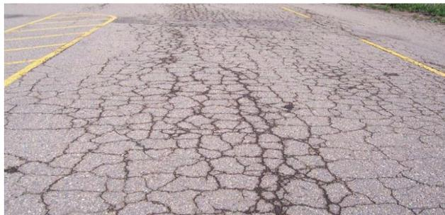
Gambar 3.2 Retak Kulit Buaya (*Alligator crack*)
