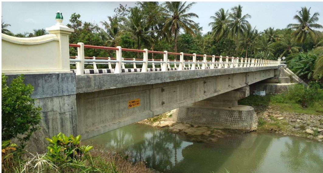
Gambar 4. 2 Foto Jembatan Sambiroto dari Samping
