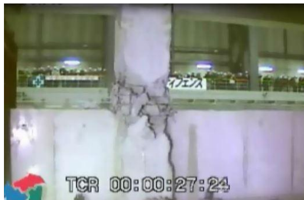
Gambar 5. 143 Kolom pendek pada lantai 1
