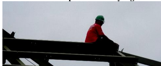
Gambar 6 Pekerja Tanpa APD Lengkap
