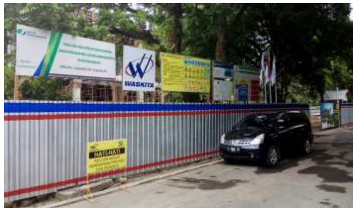
Gambar 5.14 Pemasangan Rambu K3 dan BPJS Pada Pagar Proyek UNY Yogyakarta 7 in 1
