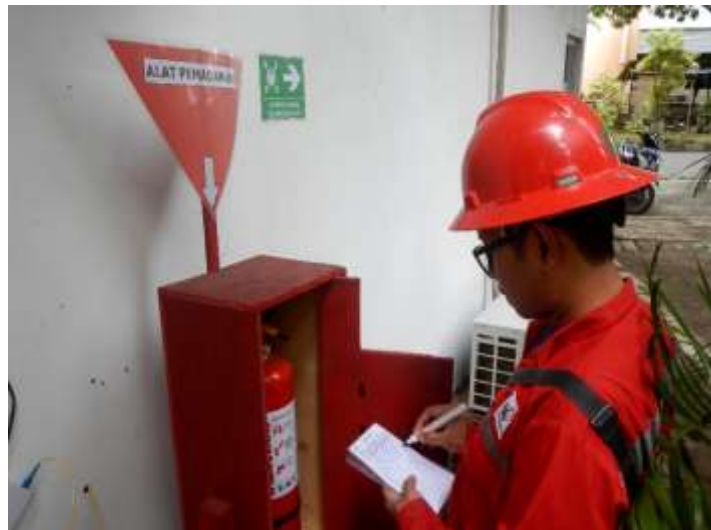
Gambar 5.24 Kegiatan Inspeksi APAR Pada Proyek UNY Yogyakarta 7 in 1 Sumber: Dokumen Pribadi, 2017
