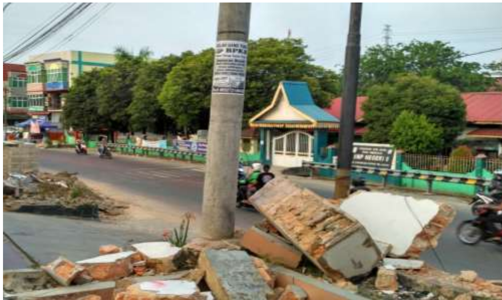
Gambar 5.10 Kawasan Sekolah Dan Kawasan Ruko Pada Ruas Jalan Simpang Baloi
