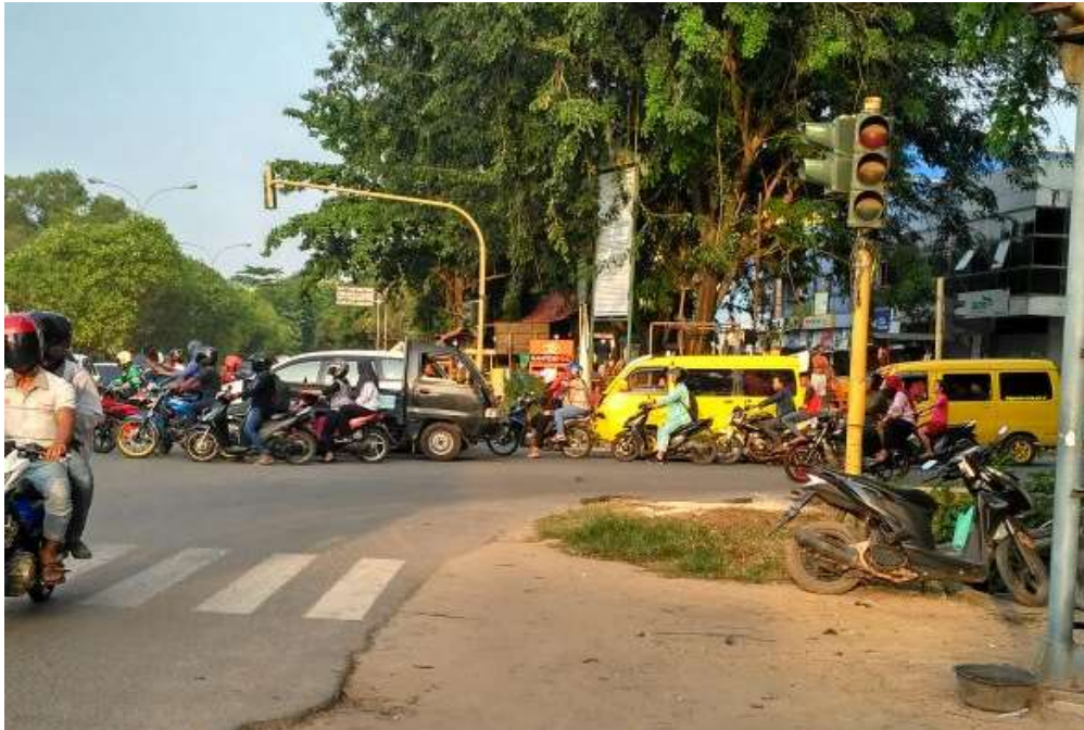
Gambar 5.9 Kondisi Lampu Lalu Lintas Yang Sudah Tidak Berfungsi Pada Ruas Jalan Sekupang
