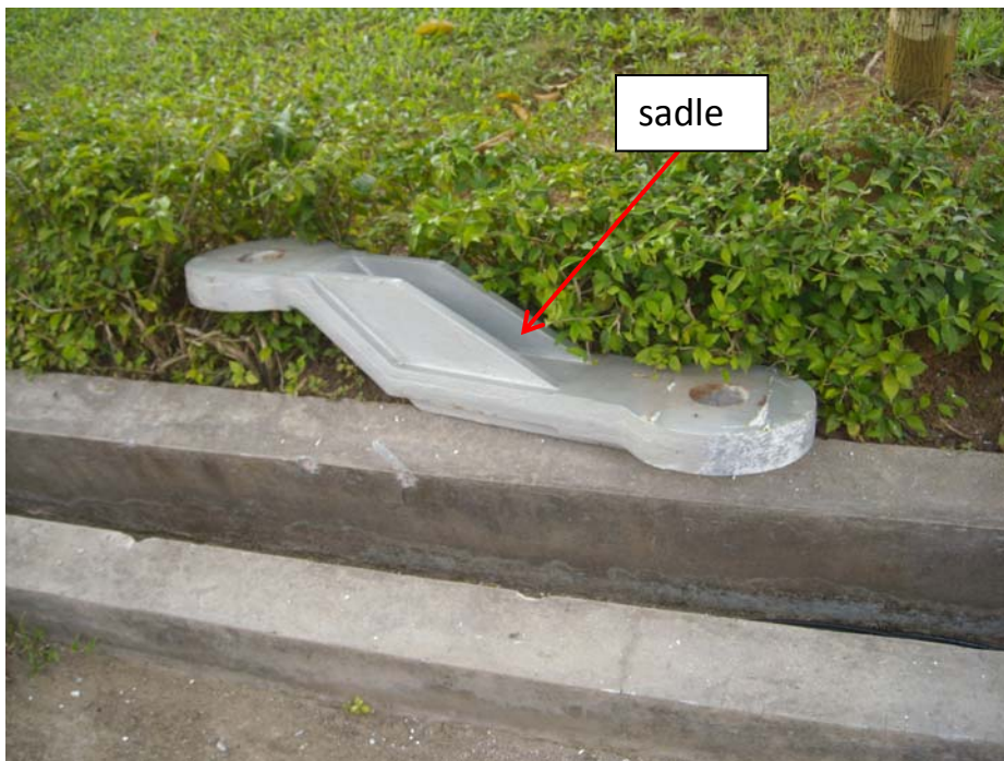
Puing-puing alat sambung kabel penggantung vertikal
