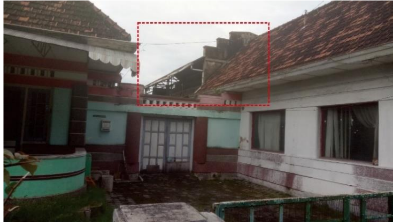
Gambar 15. Bangunan di area site
