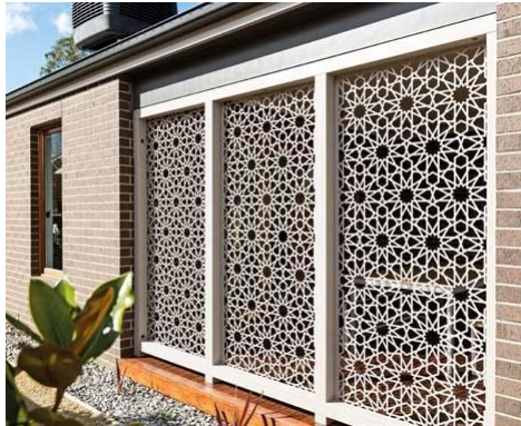
Gambar 5.6 Contoh penggunaan rooster GRC pada bangunan.
