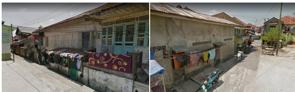
Gambar 2.12 : Kondisi Bangunan Kampung Arab Ilir Timur Pinggir Sungai Musi
