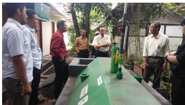
Gambar 2.64 : Biodigester Skala Rumah di Kota Bandung
