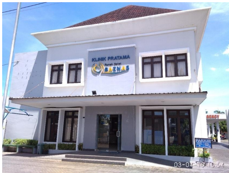
Gedung Rumah Sehat BAZNAS Yogyakarta
