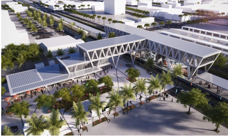
Gambar 2.32 Stasiun Fort Lauderdale
