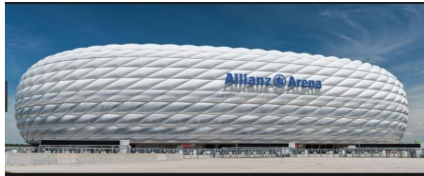
Gambar 3.20 Membrane sebagai fasad bangunan
