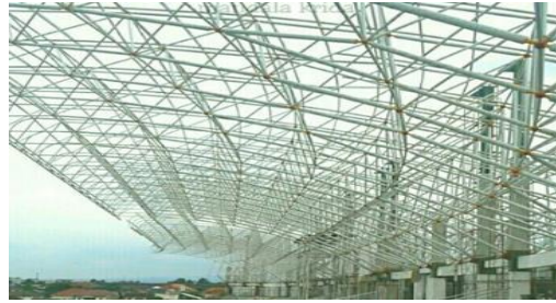
Gambar 3.19 Struktur penutup atap baja
