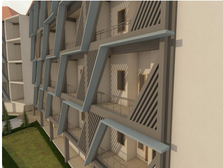
Penempatan Shading Pada Selubung bangunan Untuk Merespon Matahari
