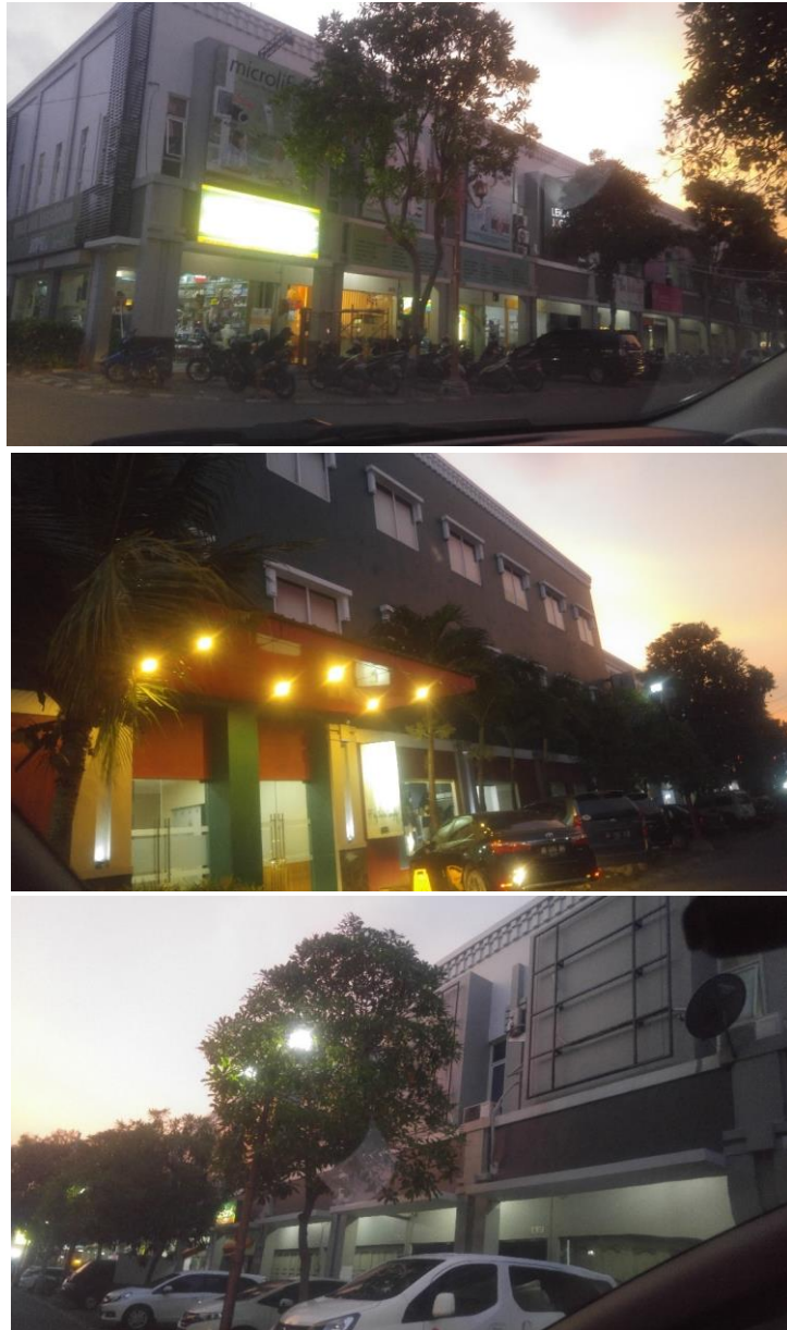
Gambar 30: Tampak dari deretan pertokoan di Yap Square (Sumber: Penyusun, 2018)
