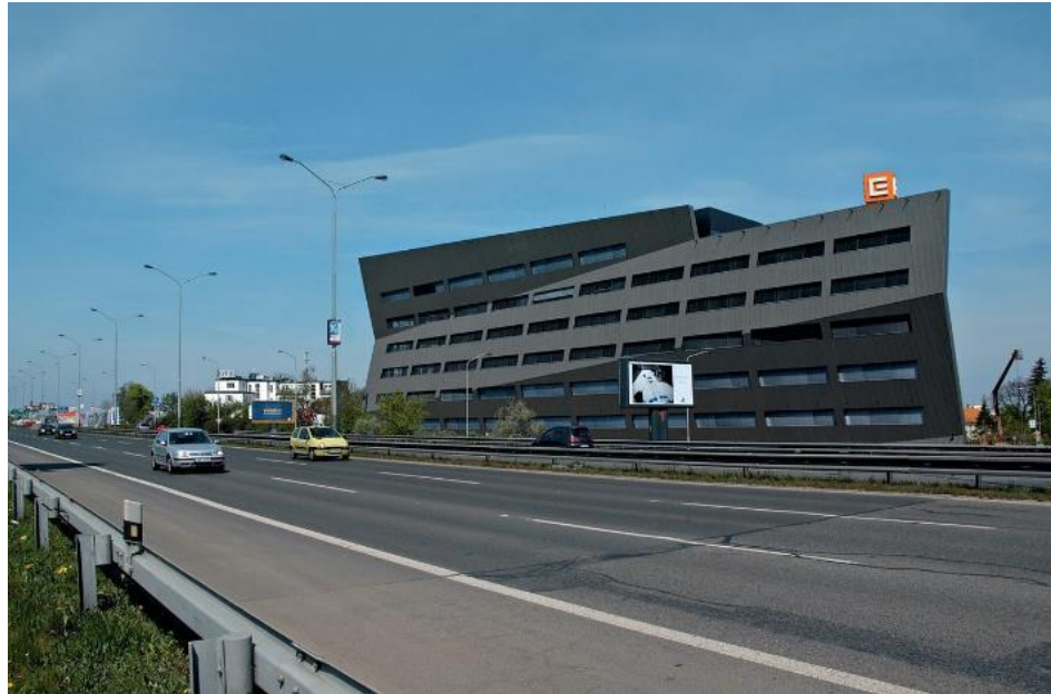
Gambar 46: Tampak dari Office Building E yang berhadapan langsung dengan jalan raya (sumber : Archdaily)
