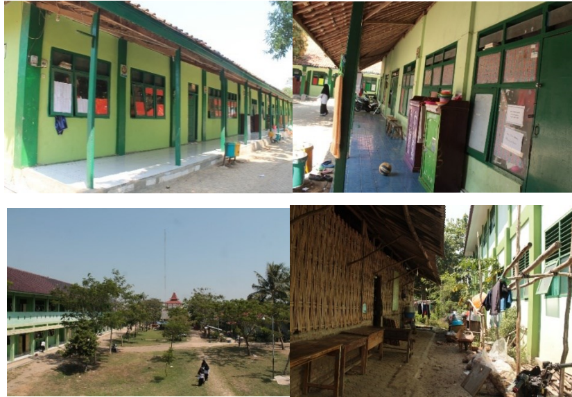
Gambar 1. 1 Kondisi Eksisting Pondok Pesantren Al-Ishlah Tajug Sumber: Fatmawati, 2017
