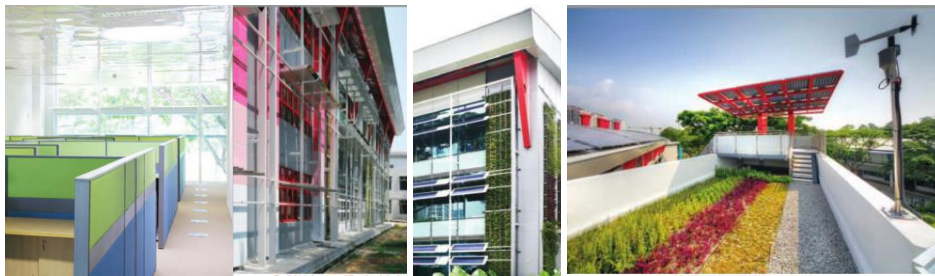
Gambar 2.11 Penerapan passive cooling pada ZEB BCA Sumber : (Wittkopf, 2015)
