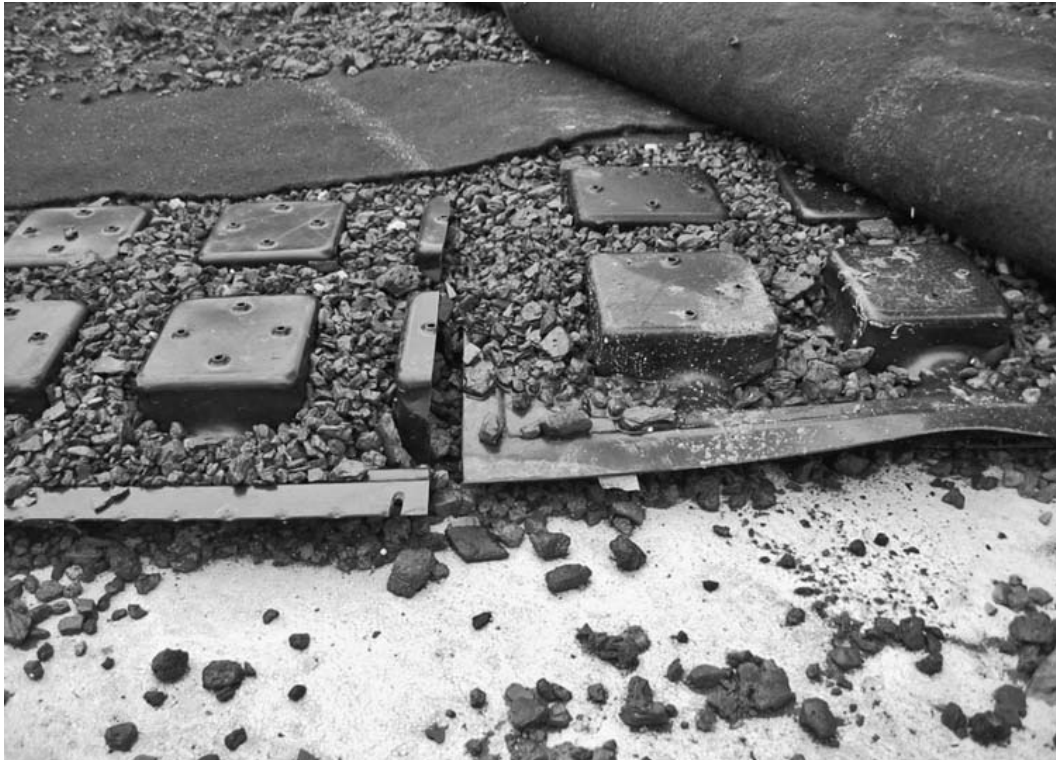
Gambar III.17. Lapisan drainase dan agregat di bawah lapisan filtrasi untuk mendukung drainase dan daya kapilaritas
