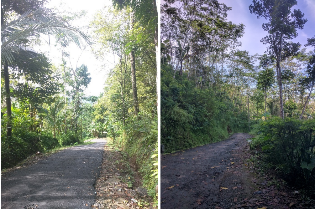
Gambar II.3. Kondisi jalan pada site
