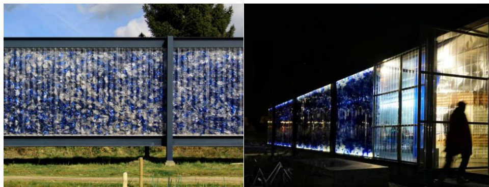
Gambar 2.4: Daur Ulang Botol Plastik sebagai Dinding Partisi
