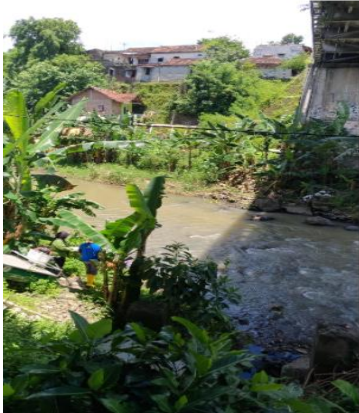
Gambar 3.6 Site 4 (Jembatan Sardjito)
