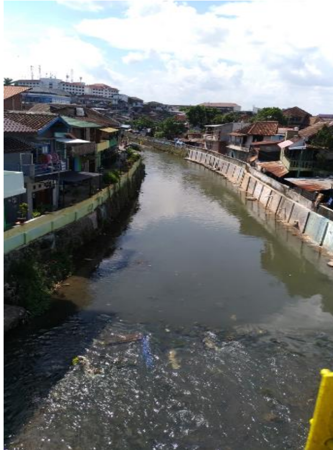
Gambar 3.7 Site 5 (Jembatan Jambu)
