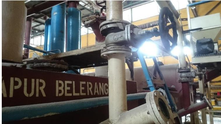
Gambar pengendalian gas SO<sub>2</sub> oleh butterfly valve manual untuk sulfitir thompson
