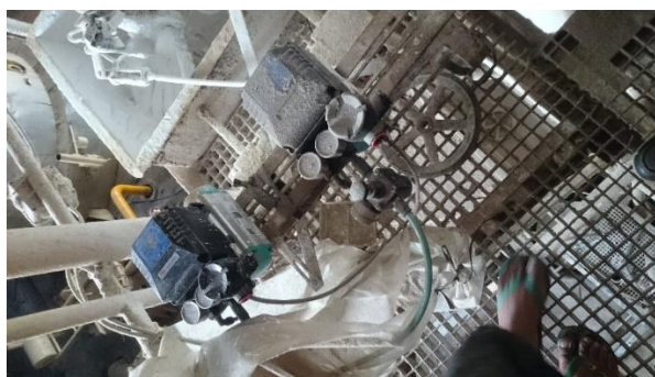
Gambar 4. 6 pengendalian susu kapur oleh pneumatic valve
