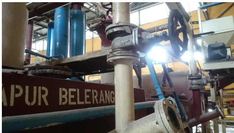
Gambar 4. 8 pengendalian gas SO 2 oleh butterfly valve manual untuk sulfiter thompson
