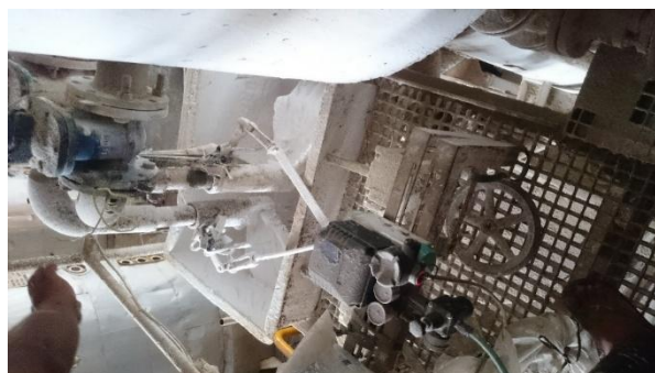
Gambar 4. 7 pengendalian susu kapur oleh pneumatic valve
