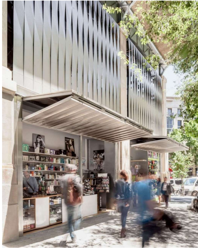
Gambar 58 Fasad bangunan dinamis yang dimanfaatkan untuk kios pasar
