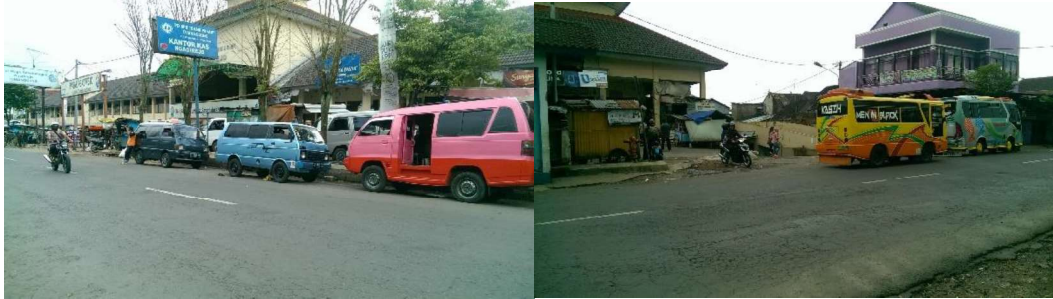
Gambar 7 Kondisi eksisting fasilitas Pasar Wage Adiwiningun
