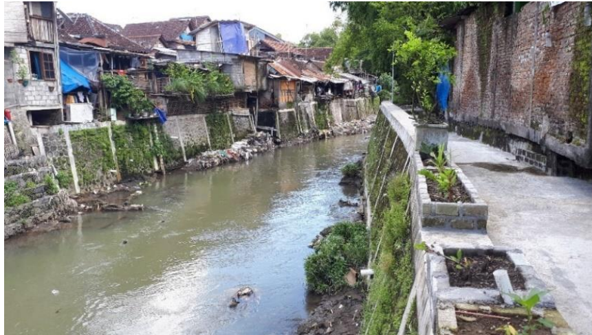
Gambar 1.4 Permukiman di Bantaran Kali Winongo, Yogyakarta Sumber: Penulis, 2018
