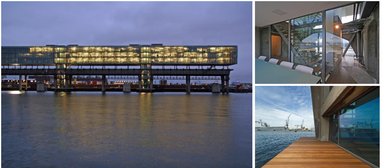
Gambar 14. Bangunan Industri dan Kantor Kraanspoor, Belanda
