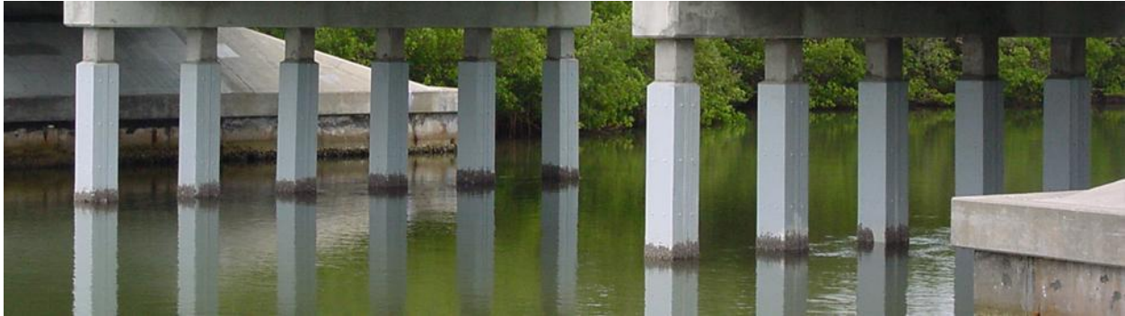
Gambar 12. Pondasi Tiang Pancang
