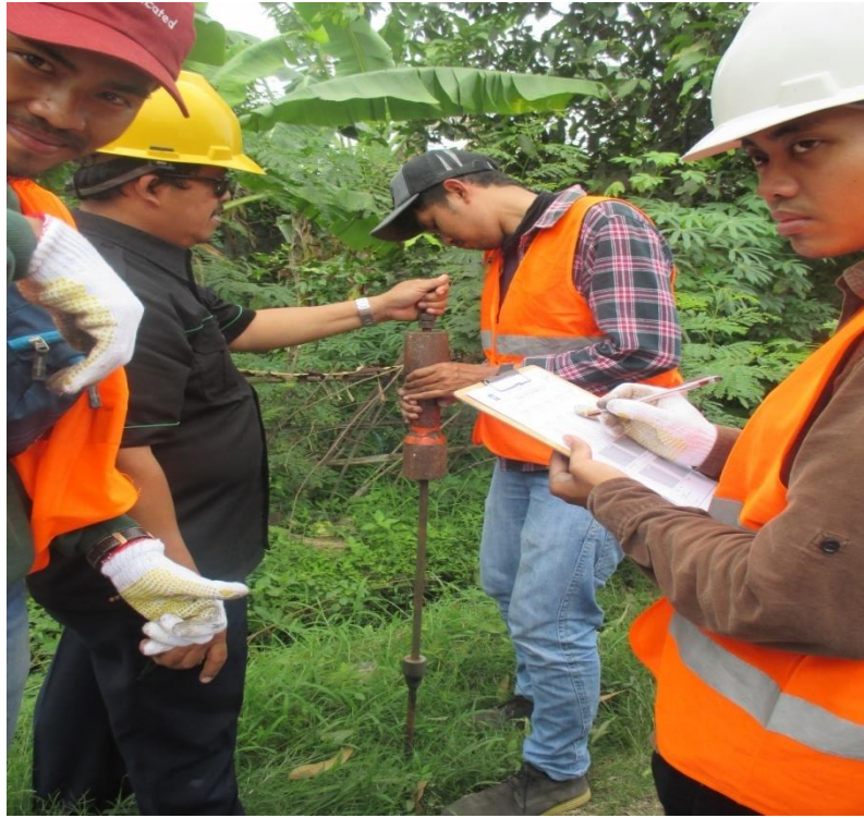
Gambar L – 7.5 Pengambilan Data CBR Lapangan dengan Alat Dynamic Cone Penetrometer (DCP)
