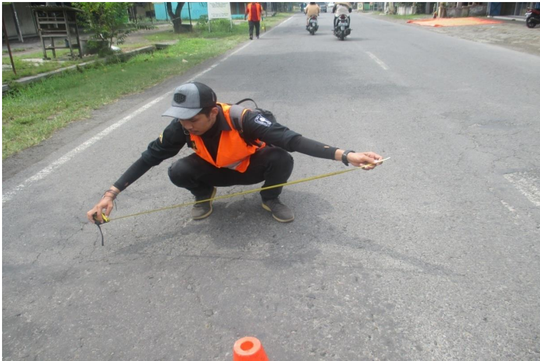
Gambar L – 7.1 Pengambilan Data Evaluasi Kondisi Kerusakan Jalan
