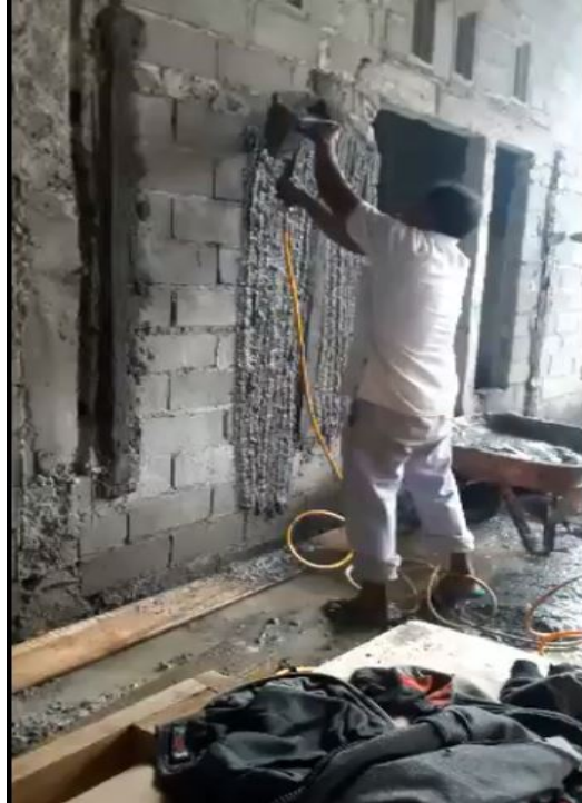
Lampiran 4. Foto Perbandingan Pekerjaan Plester Dinding Menggunakan Kedua Metode Tersebut
