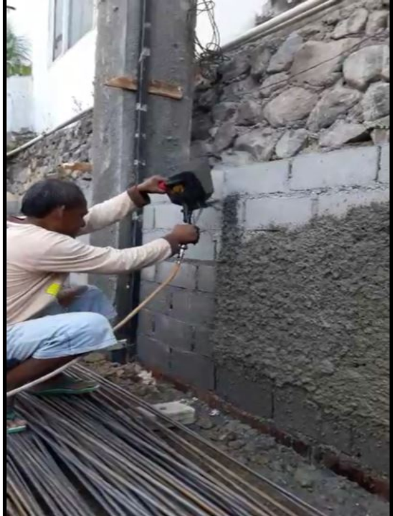
Lampiran 2. Foto Pekerjaan Plester Dinding Menggunakan Metode Shotcrete (Alat Lepo)
