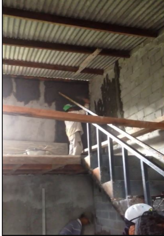
Lampiran 3. Foto Pekerjaan Plester Dinding Menggunakan Metode Konvensional
