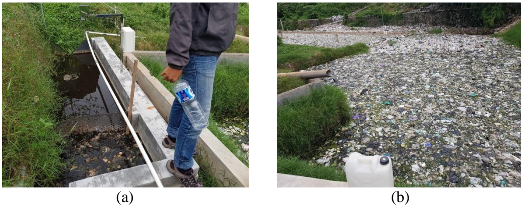
Gambar 4. 1 (a) Screen dan (b) Kolam Pengendap IPL Piyungan
