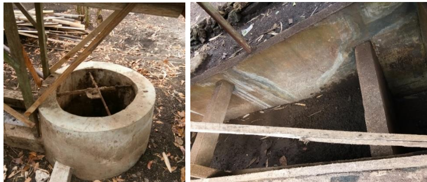
Gambar 3.2 Bangunan pelengkap ( Mixing unit dan Sludge Drying Bed )
