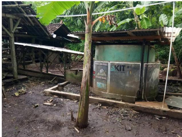
Gambar 3.7 Reaktor biogas Desa Pucanganom setelah diperbaiki
