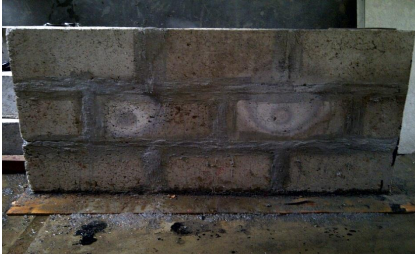
Gambar 5.20 Kondisi Dinding Setelah Dibakar
