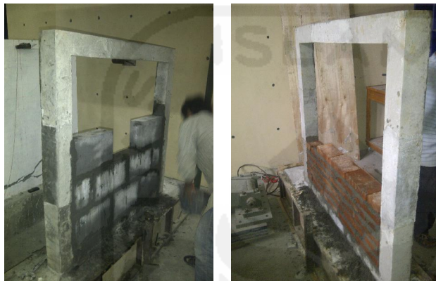
Gambar 4.22 Proses pemasangan Batako UII dan Bata merah
