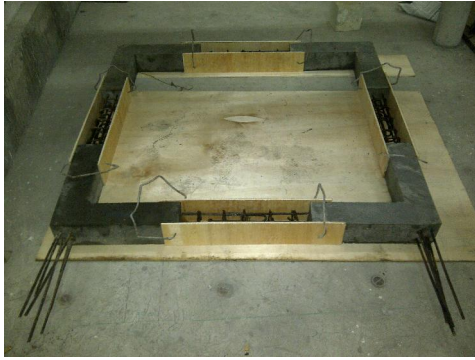
Gambar 4.21 Perangkaian komponen portal beton pracetak
