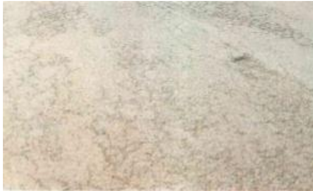
Gambar 3.6 Retak Kulit Buaya
