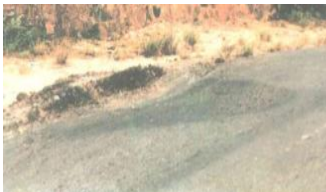
Gambar 3.4 Penurunan/Amblas
