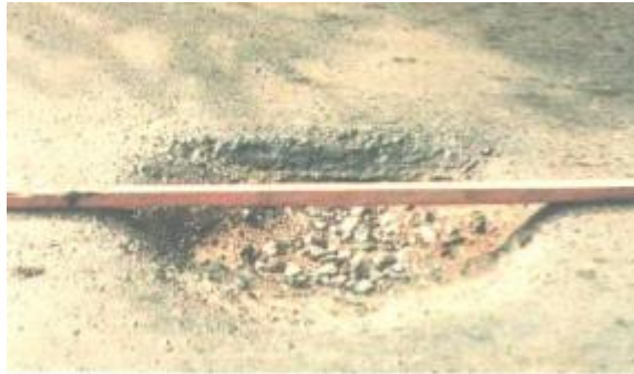
Gambar 3.1 Lubang (Sumber : Bina Marga, 2011)
