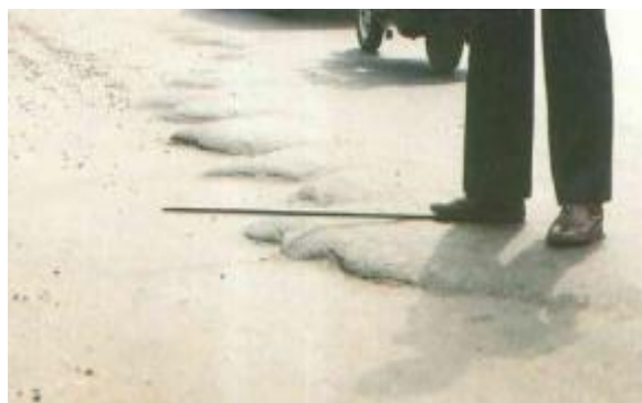
Gambar 3.5 Jembul (Sumber : Bina Marga, 2011)
