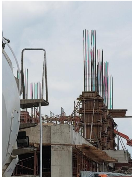
Gambar 3.4 Pemasangan Bekisting
