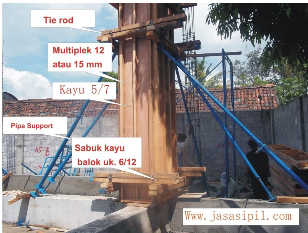
Gambar 3.1 Bekisting Konvensional
