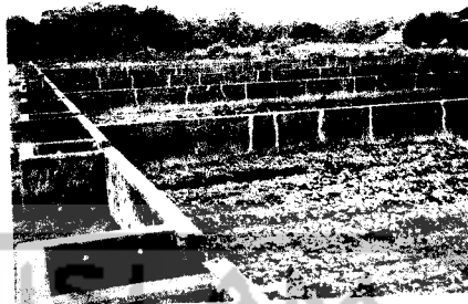
Gambar. 2.1. Sludge Drying Bed Pada Instalasi Pengolahan Air Buangan Limbah (IPAL) Domestik Sewon, Bantul
