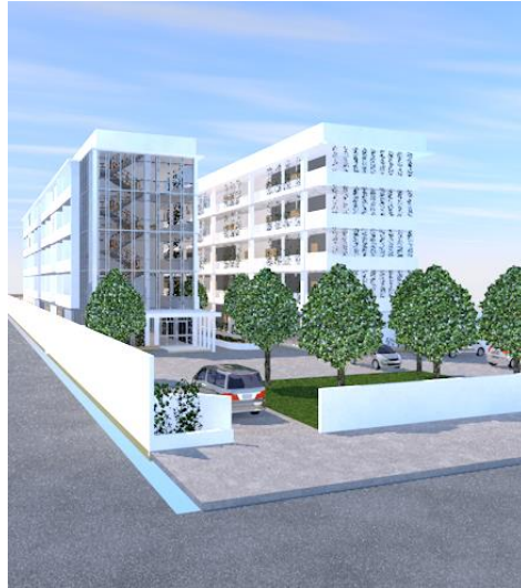
Gambar 4.2 tampak depan bangunan hostel
