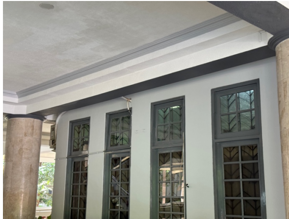
Gambar 5. 20 Kondisi ventilasi gedung rektorat
