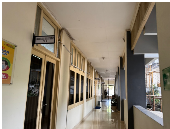
Gambar 5. 24 Pencahayaan pada lorong gedung rektorat
