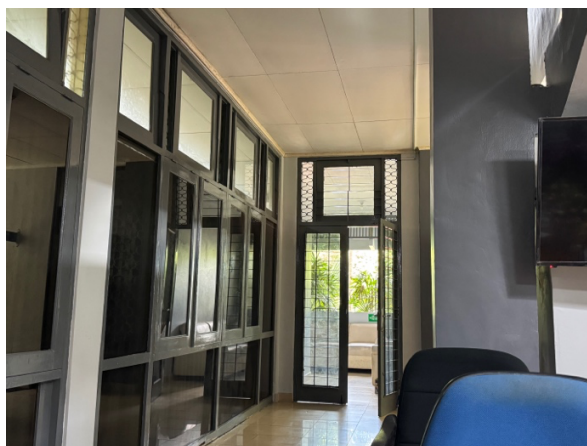
Gambar 5. 22 Kondisi ventilasi gedung rektorat
