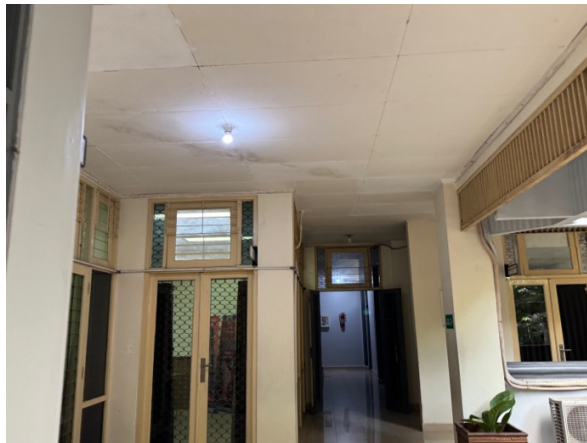
Gambar 5. 21 Kondisi ventilasi gedung rektorat
