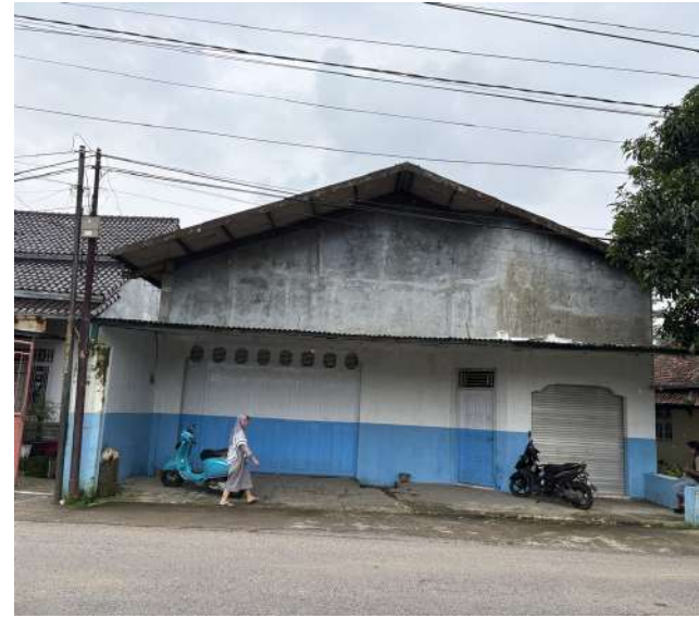
Gambar 14. Tampak Depan Pabrik Eksisting Sumber: Dokumentasi Perancang, 2026
