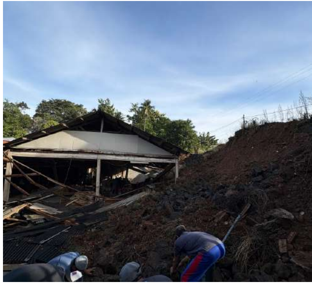
Gambar 13. Bencana Longsor yang Terjadi di Pabrik Sumber: Dokumentasi Perancang, 2026
