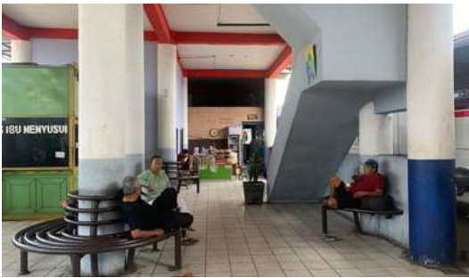
Gambar 6. Area ruang tunggu terminal tidak memadai Sumber: Penulis
