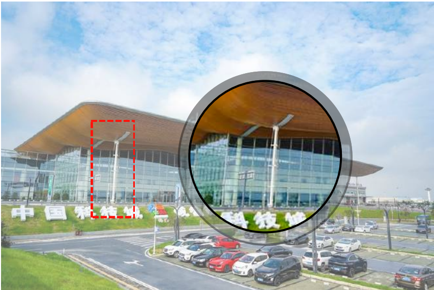
Gambar 94. kanopi dengan kolom baja ramping yang menjadi fokus penelitian struktur Sumber: https://mianyang.scol.com.cn
