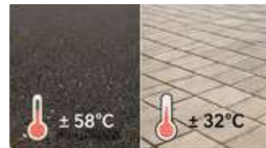
Gambar 50. Perbandingan suhu permukaan material perkerasan. Sumber: Penulis
