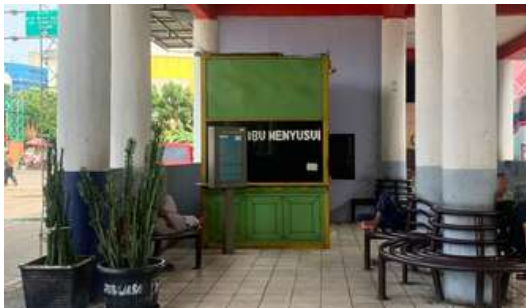
Gambar 9. Fasilitas Ruang laktasi yang kurang aman Sumber: Penulis
