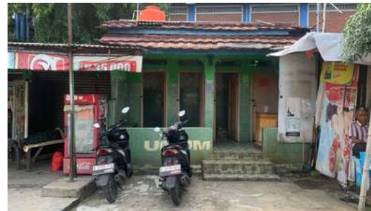
Gambar 10. Toilet umum terkesan kumuh Sumber: Penulis
