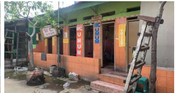
Gambar 11. Toilet umum terkesan kumuh Sumber: Penulis
