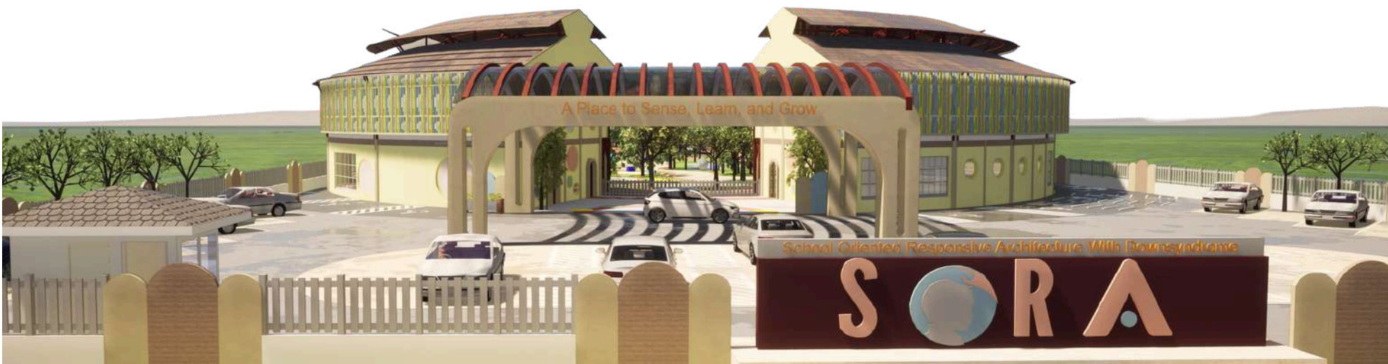
Area tampak depan bangunan
