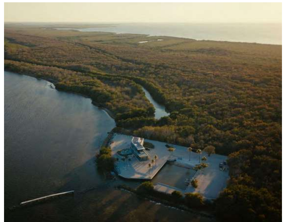
Gambar 3.1.2 Situasi Kawasan Van der Vlugt Residence
