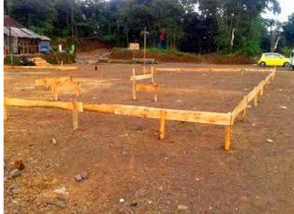
Gambar 5.25 Contoh Pemasangan Bowplank
