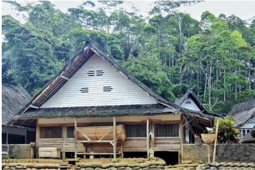
Gambar 3. 2 Masjid Adat Kampung Naga
