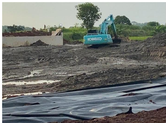
Gambar 1. 1 Kondisi Perbaikan Tanah Lunak Metode Soil Replacement Dikombinasikan dengan Geosintetik
