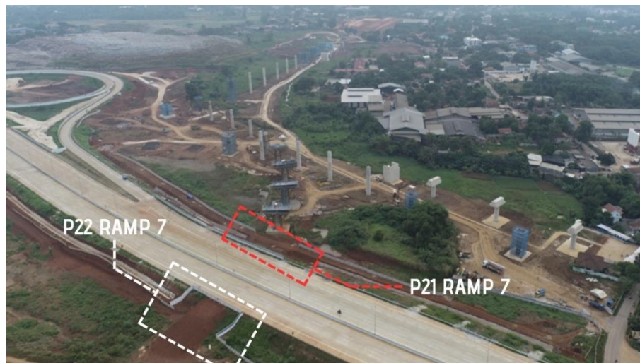
Gambar 5. 35 Lokasi Pekerjaan Borepile Pier 21 dan Pier 22 Ramp 7 (Sumber: Dokumentasi Drone Perusahaan, 2025)
