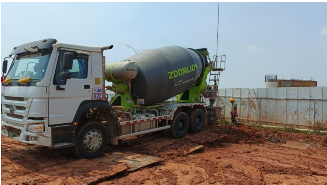
Gambar L-6. 6 Lokasi Pekerjaan Pier 21 Ramp 7
