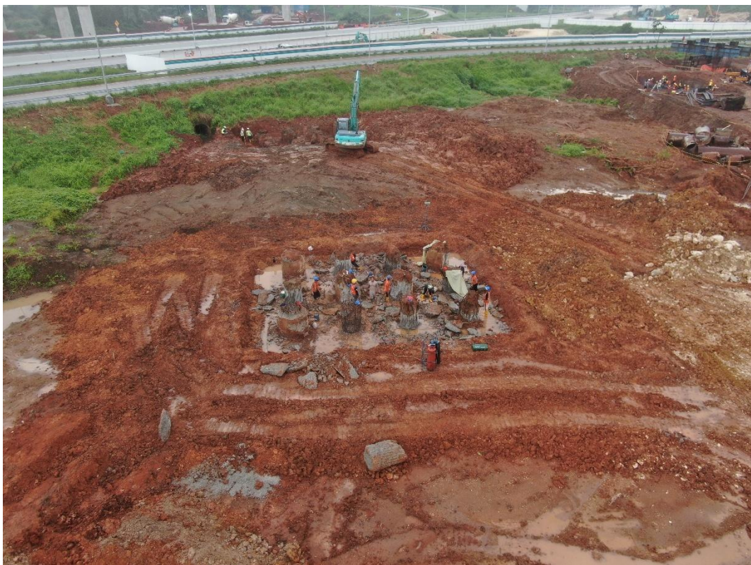
Gambar L-6. 2 Pekerjaan Penggalian Boredpile
