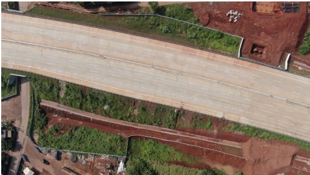
Gambar L-6. 5 Lokasi Pekerjaan Pier 21 dan Pier 22 Ramp 7
