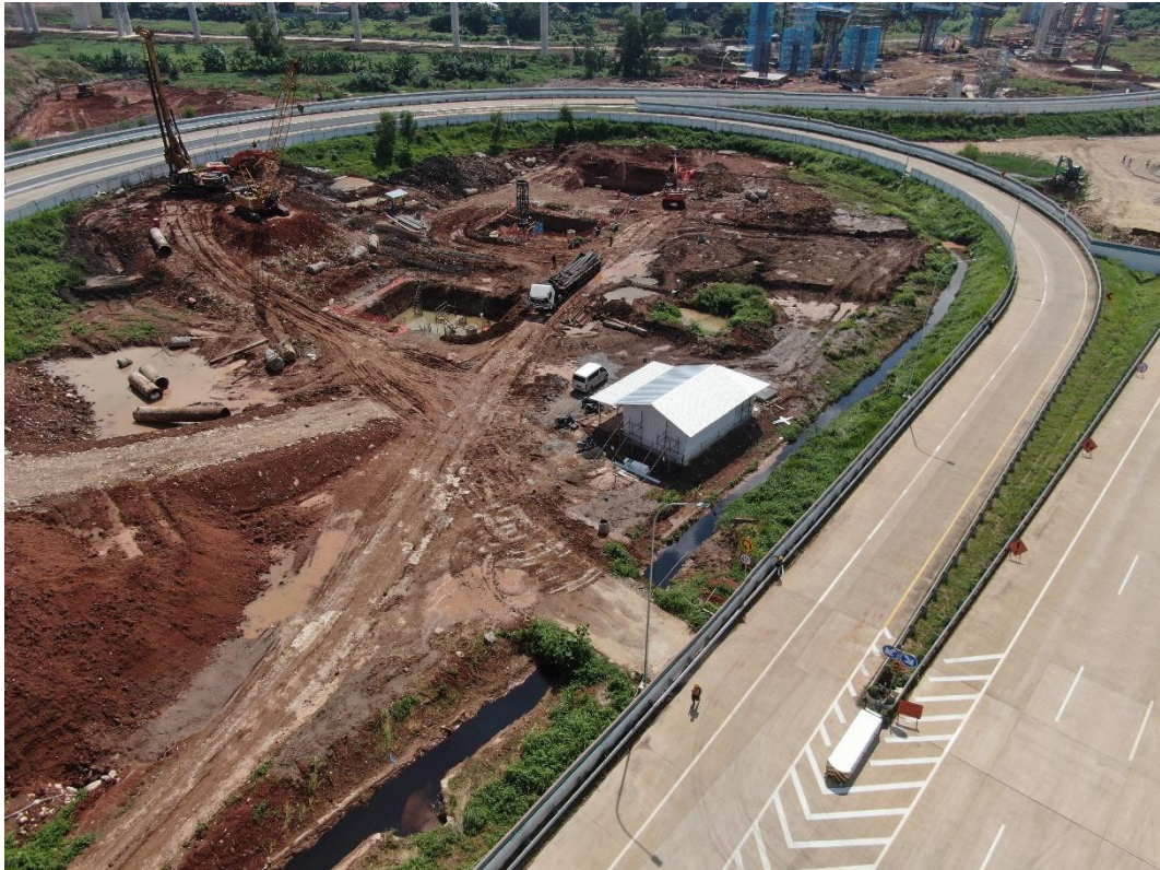
Gambar L-6. 3 Pekerjaan Borepile Dalam Loop CCT
