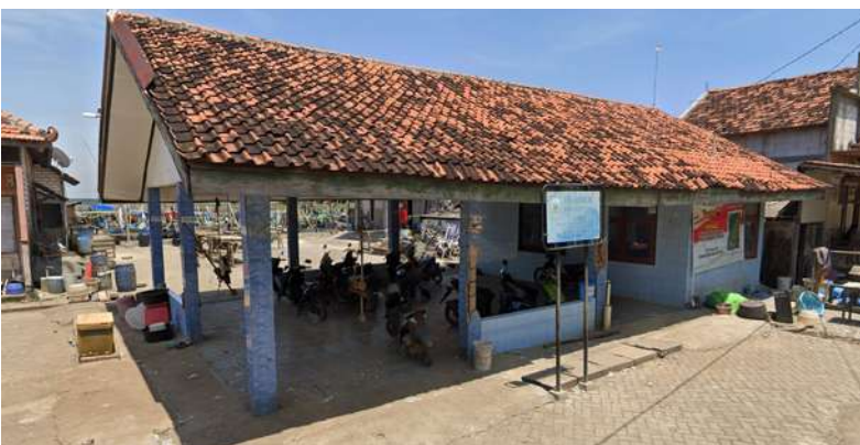
Figure 1.14 TPI Kedung Mutih
