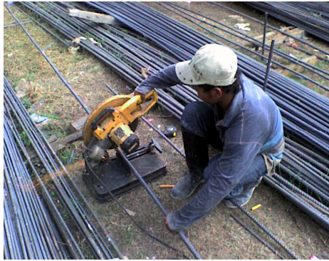
Gambar 5.1 Pekerjaan cutting
