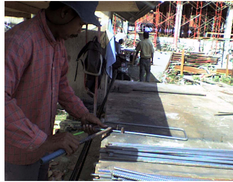
Gambar 5.2 Pekerjaan bending
