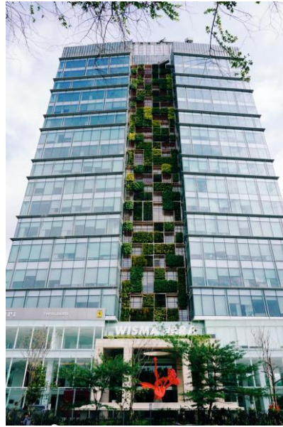
(Gambar 2.2 Gedung Wisma MRA yang Menaungi HerWorld Indonesia. Sumber: property.jll.co.id , 2025 )
